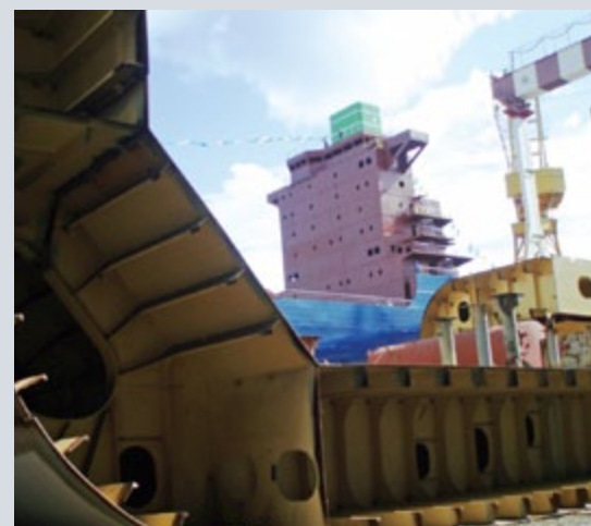
Obras na carreira do EISA
